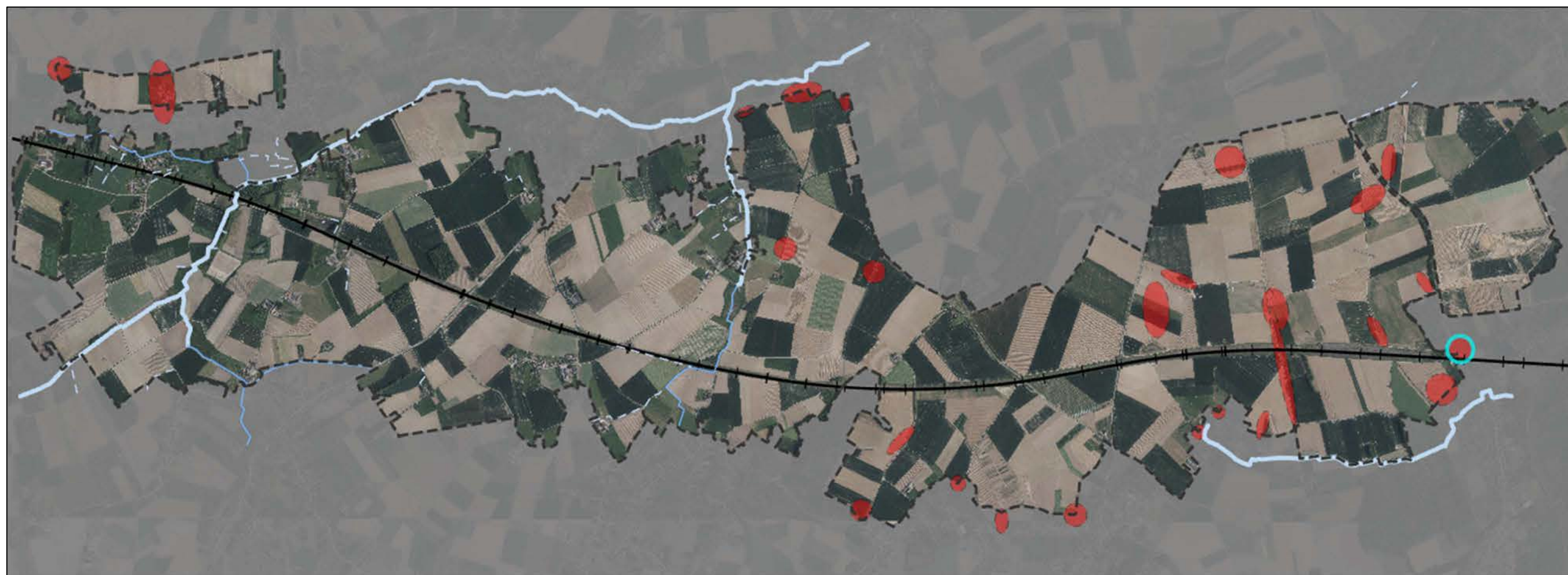
Figure 14: localisation des points noirs en terme d'érosion et de coulée boueuses
